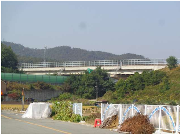
교량 측면 전경
