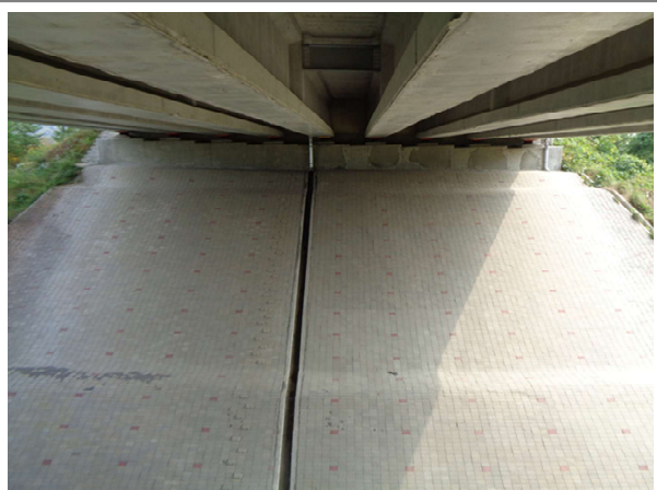
교량 하부 전경
