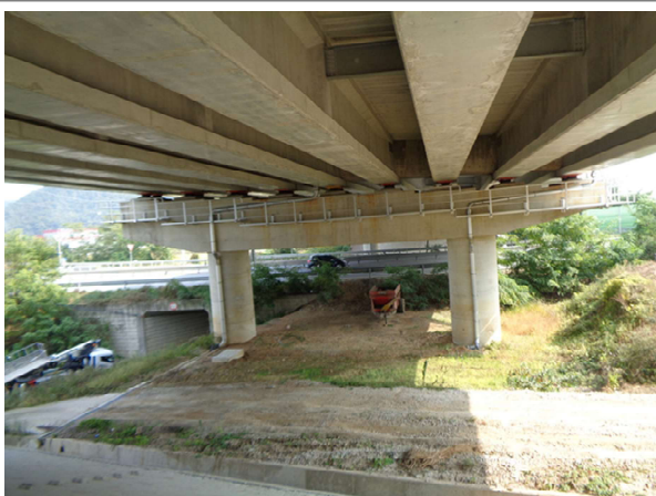
교량 하부 전경
