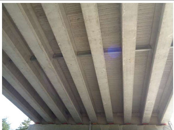
교량 거더 전경
