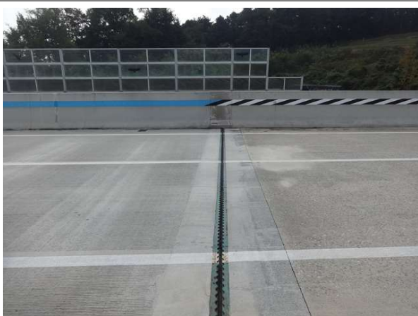
교량 상부 전경
