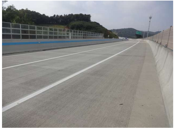
교량 상부 전경
